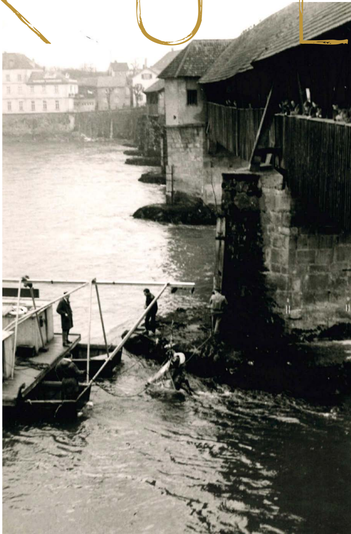
Reparaturarbeiten an der Holzbrücke
